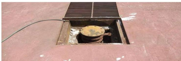
Figura 13: Ponto de acesso com válvula para acoplamento
